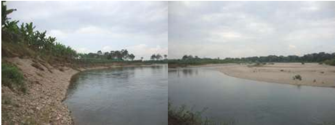
Figuras 28 y 29. Erosión provocada por el cauce hídrico del Río Valle Nacional en la localidad de El Fortín.
