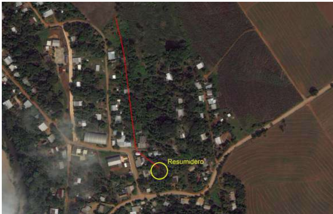
Figura 82. Se observa un “resumidero” (dentro del círculo color amarillo) que debe ser drenado con la construcción de un canal con una posible trayectoria marcada en color rojo.
