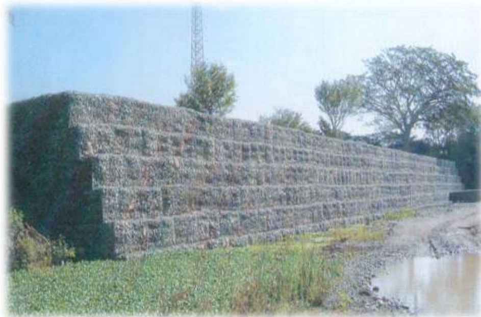
Figuras 78 y 79. Protecciones marginales con gaviones tipo escalón o escalonado.
