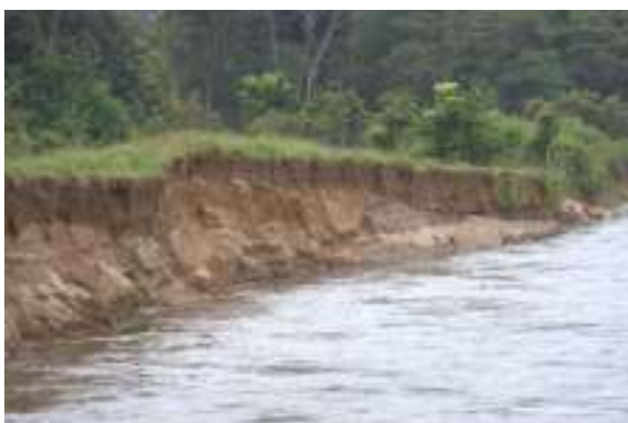
Figura 70. Socavación y arrastre de bordos en el río
