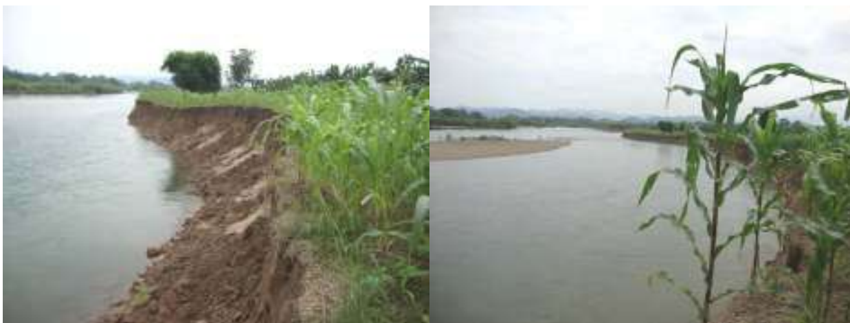
Figuras 26 y 27. Erosión provocada por el cauce hídrico del Río Valle Nacional en la localidad de La Candelaria.
